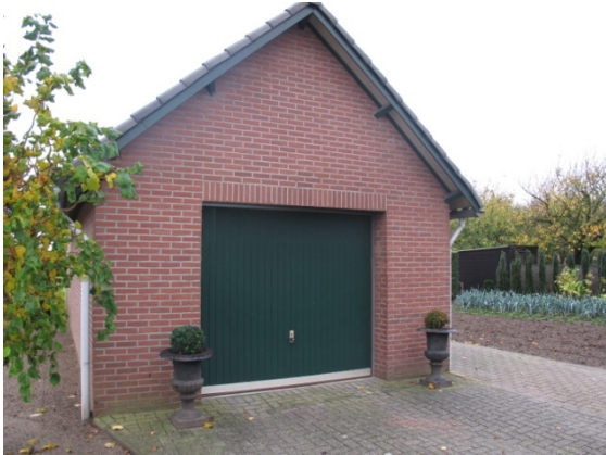
Gesloten gebouw. Spouwmuur. Geen openingen voor invliegen.
