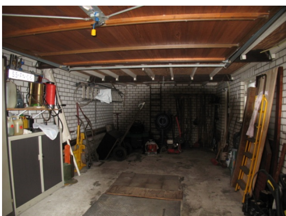
Interieur garage v.v. plafond. Geen enkel spoor van welk dier dan ook.
