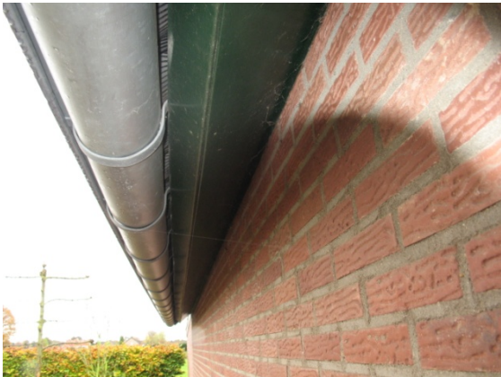
Onderzijde overstekken voorzien van gladde betimmering.
