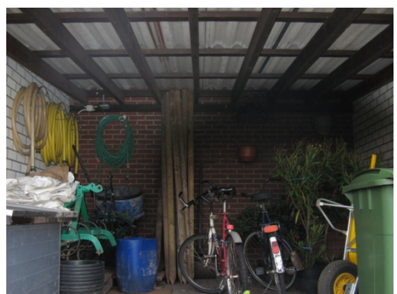
Vergunningsvrije overkapping. Geen spoor van dieren.
