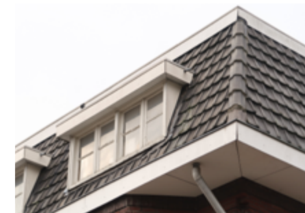
Werk aan de winkel: houten details weggewerkt achter trespaplaten.
