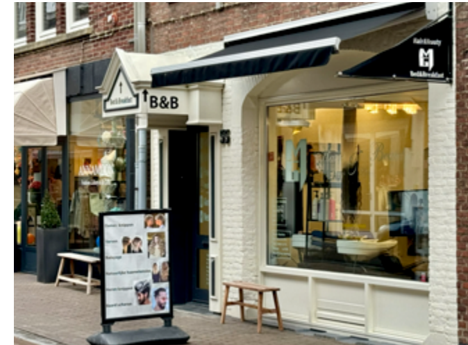
Tip 2e. Roodbruine baksteen is het basismateriaal in de binnenstad, geen gevelonderdelen schilderen.
