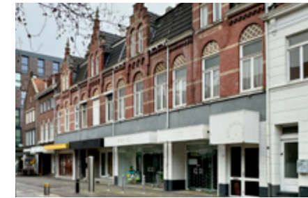
Werk aan de winkel: begane grond losgesneden van de verdiepingen.
