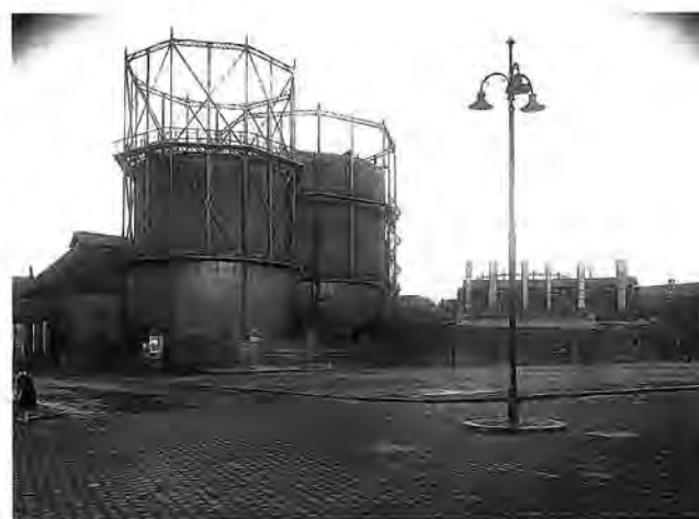
48 De gasfabriek, begin twintigste eeuw
