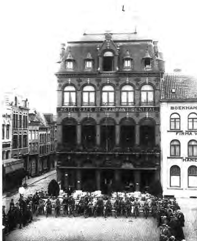
65a Hotel 'Central' aan de Markt (opname 1914)
