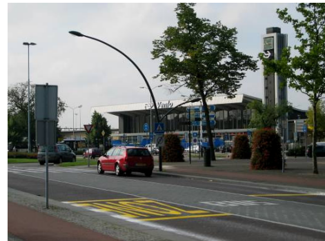
het station met de beeldbepalende luifel en toren terzijde van het Koninginneplein
