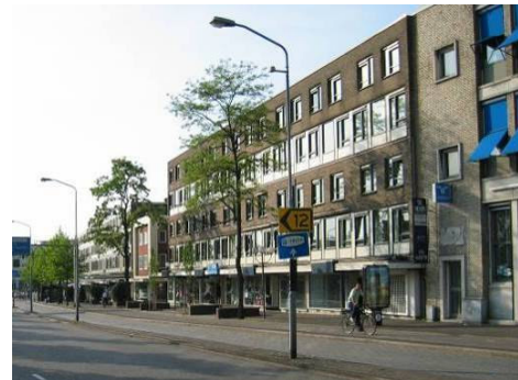
langgerekte bebouwingswanden met een collectief karakter en horizontale accenten flankeren de route
