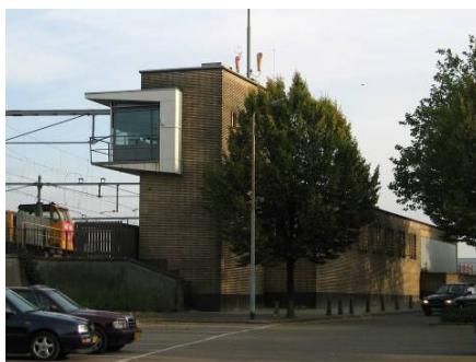
seinhuis met dienstgebouw Sloterbeekstraat z.n.
