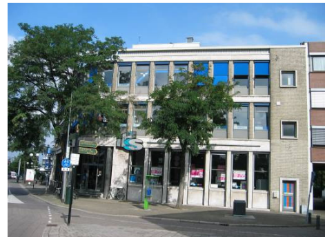
het voormalige bankgebouw op de hoek van de Koninginnesingel en de Spoorstraat
