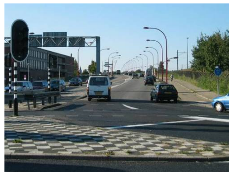
de twee rijen lantaarns en de "wachters" geven richting aan de gebogen en flauw hellende route
