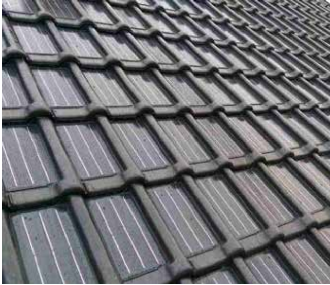
Figuur 2.18 Zonnepanelen geïntegreerd in dakpannen
