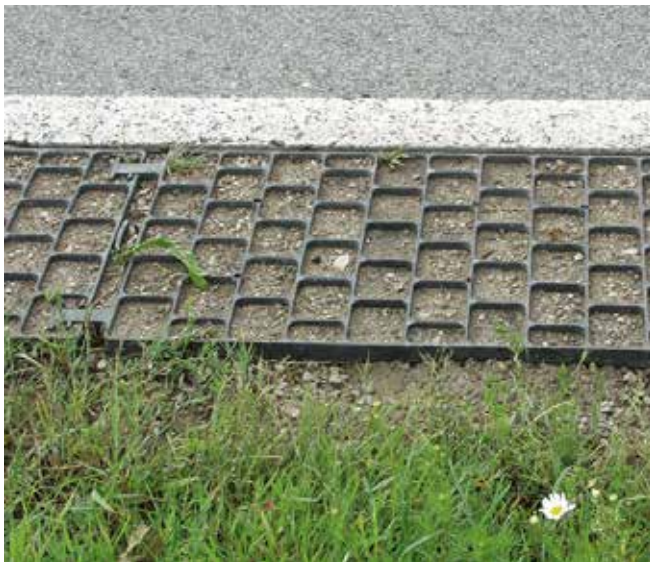
Figuur 4.20 Voorbeeld van een verstevigde berm
