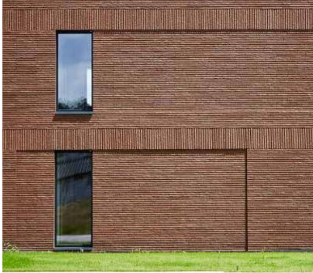
Figuur 3.9 Kozijnen in een neutrale, donkere kleurstelling
