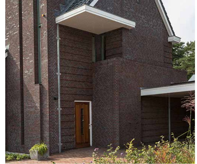
Figuur 3.47 Eigentijdse baksteenarchitectuur met aandacht voor detailering
