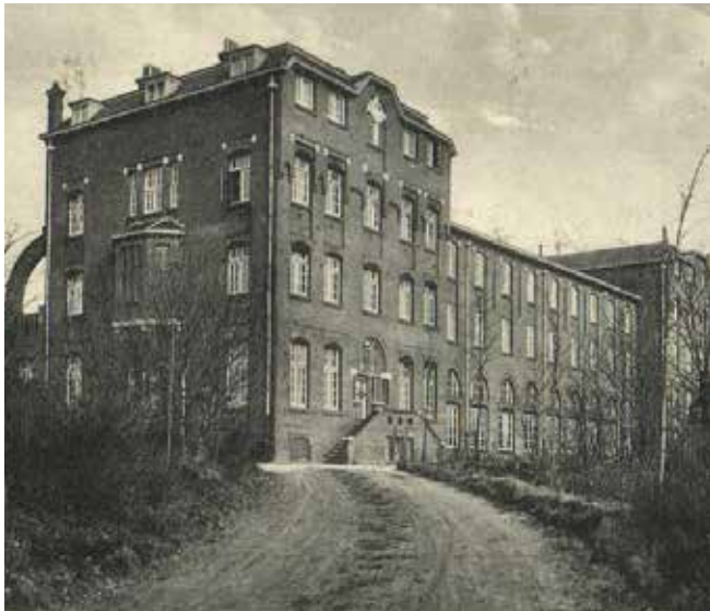
Figuur 3.4 Toegang via de Leutherweg
