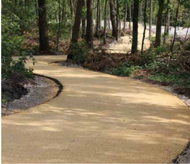
Figuur 4.13 Afgestrooid asfalt voor calamiteiten / LV route Leutherweg
