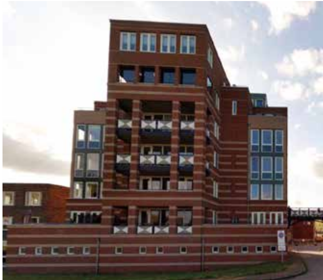
Figuur 3.28 Accent door het laten verspringen van de verdiepingen
