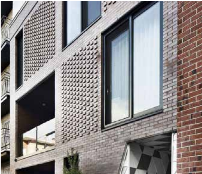
Figuur 3.31 Loggia in combinatie met detaillering in de gevel
