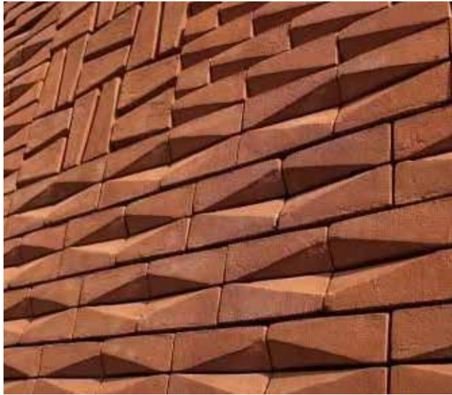
Figuur 3.18 Bakstenen met afwijkende formaten geven een patroon
