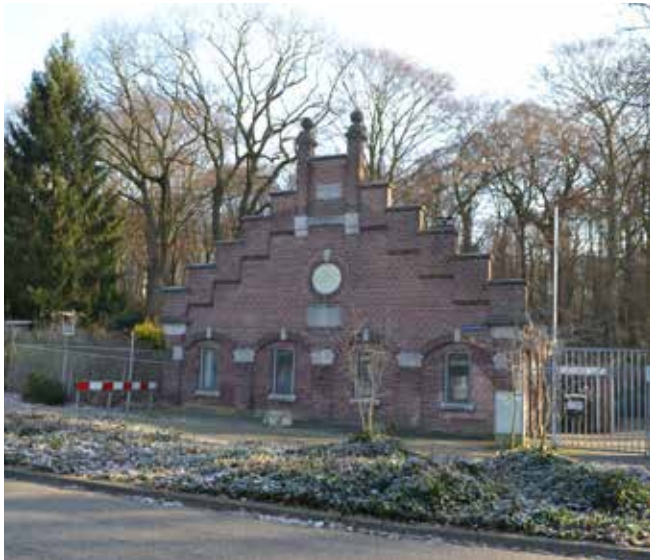
Figuur 1.5 Waterleidinggebouw (nr. 4)
