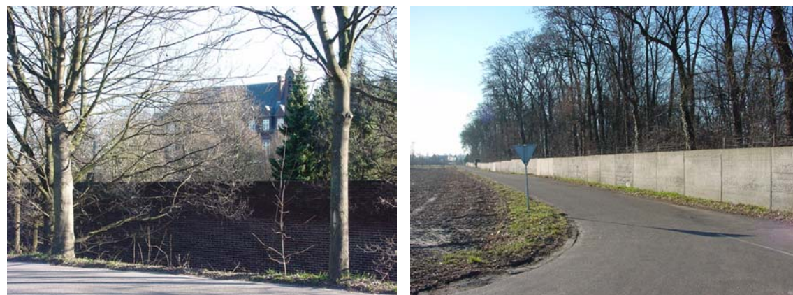
Hoge bakstenen ommuring aan de Kaldenkerkerweg
