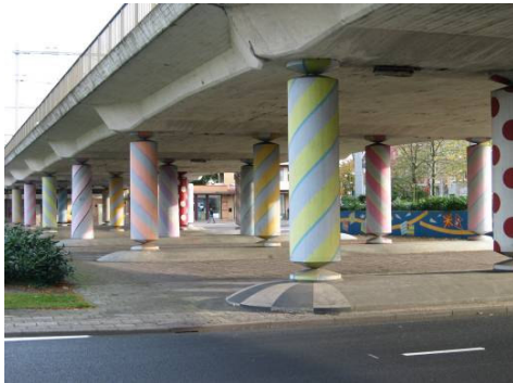
spoorviaduct Roermondse Poort
