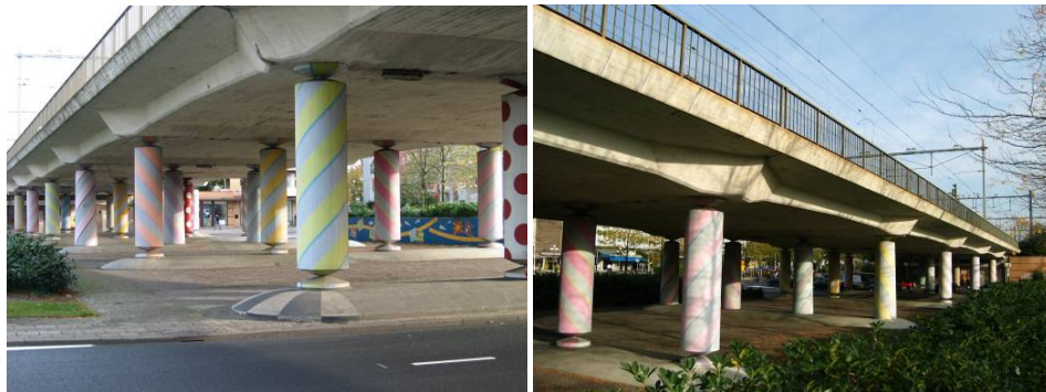
Spoorviaduct, Koninginnesingel/ Roermondse Poort architect J. Klijnen, 1957
