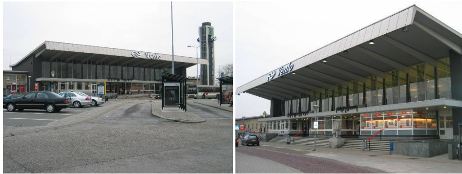
Centraal Station, Stationsplein 1, Venlo architect K. van der Gaast. 1958
