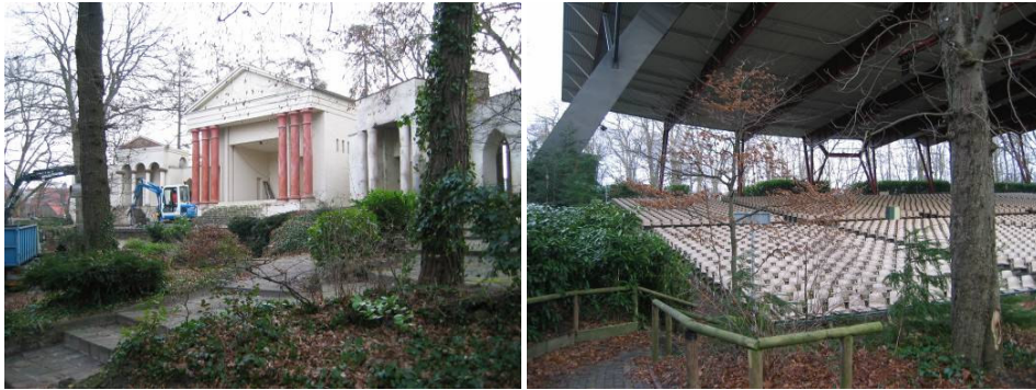
openluchttheater De Doolhof, De Drink, Tegelen decor architecten: W. Siebgens, P. van Gerven en A. Boosten, 1946 tribune: 1967
