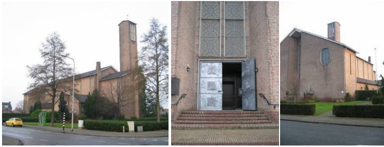
Jozefkerk, Gulickstraat 2 , Tegelen architect G. Snelder, 1952
