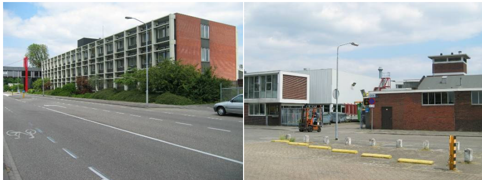
fabriekcomplex Océ Venlo, St. Urbanusweg 102, Genooyerbergen 35, Rummerkampstraat 32
