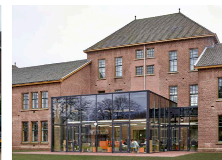
Tapijnkazerne Maastricht voor en na restauratie
