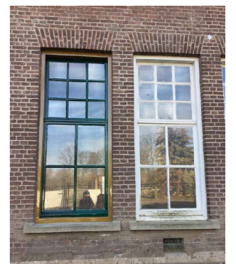
restauratie bestaande houten kozijnen Tapijnkazerne
