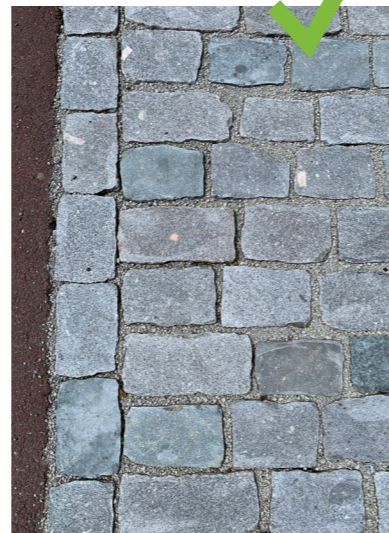
Extra grote stenen toepassen als passtuk
