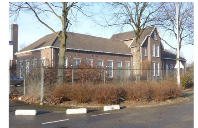
huidige staat voormalige kantine I, Frederik Hendrikkazerne
