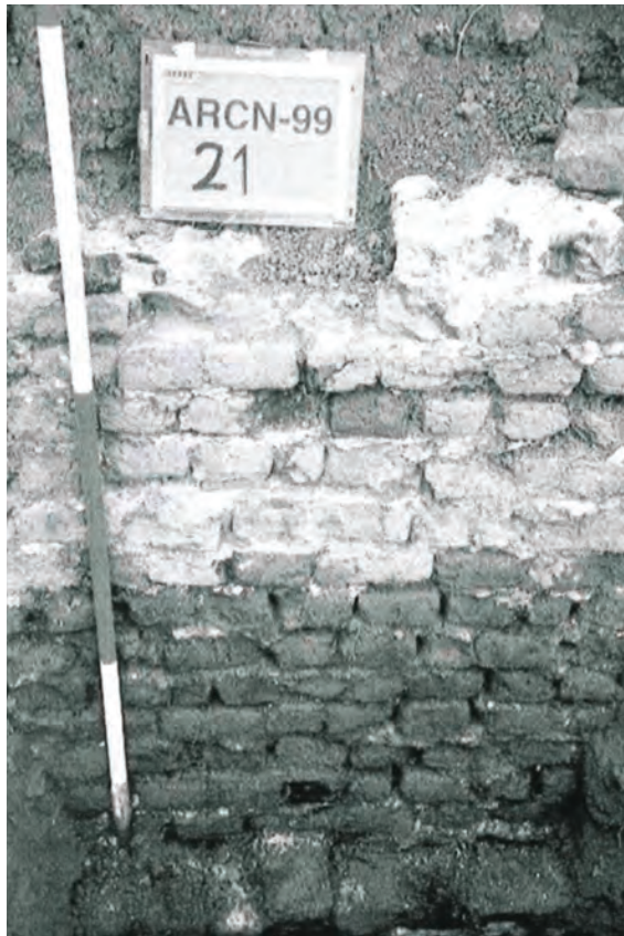
Figuur 27. Mergelmuur van de watermolen aan de Haagbeek bij Lomm (uit: Mulder, 2002).
