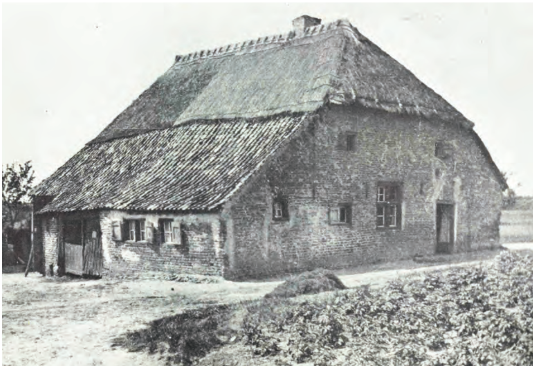
Figuur 86. Historische boerenwoning met strodak en ankerjaartal 1787. Ze stond tegenover de plek waar nu pand Bong 14 staat. In 1924 werd ze afgebroken (uit: Keltjens, e.a., 1997).
