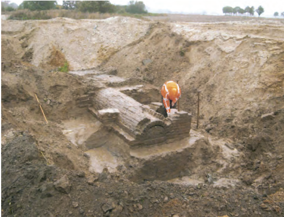
Figuur 139. Gemetselde duiker die de Haagbeek onder de veldweg op het Maasveld door leidde (uit: Prangma, 2008).
