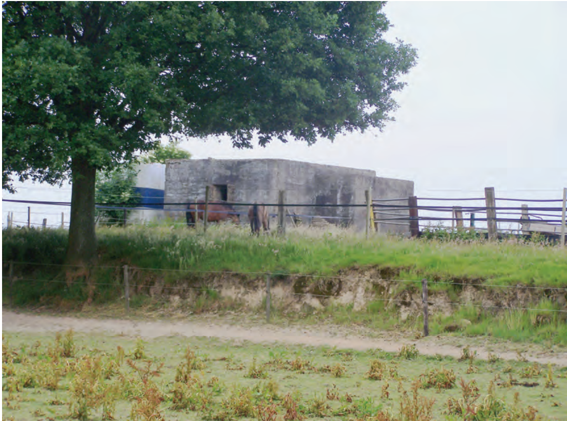
Figuur 122. Bunker van het schijnvliegveld in Schandelo.
